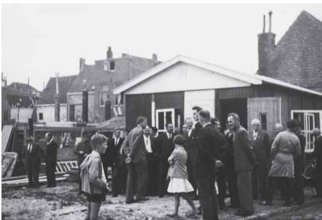
Belangstellenden op de dag van het heien van de eerste paal van de nieuwe melkfabriek aan de Walensingel.
