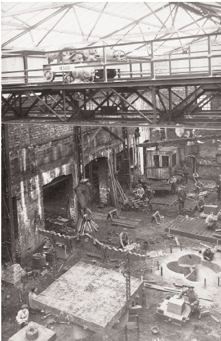
Het maken van een schepsschroef in de werkplaats, ca. 1920. (Fotocoll. F. Jilleba, Middelburg)
