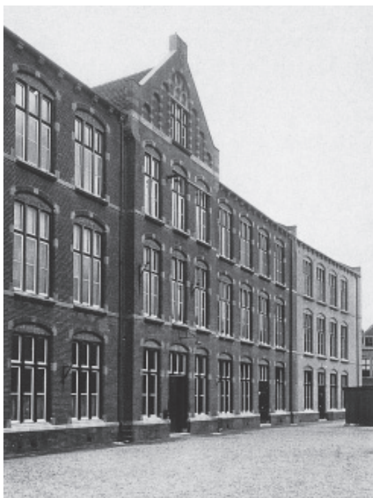
De linkerleugel van het kazernegebouw te Middelburg (Koningstraatkant), gezien vanaf de binnenplaats. (Coll. J. Braat)
