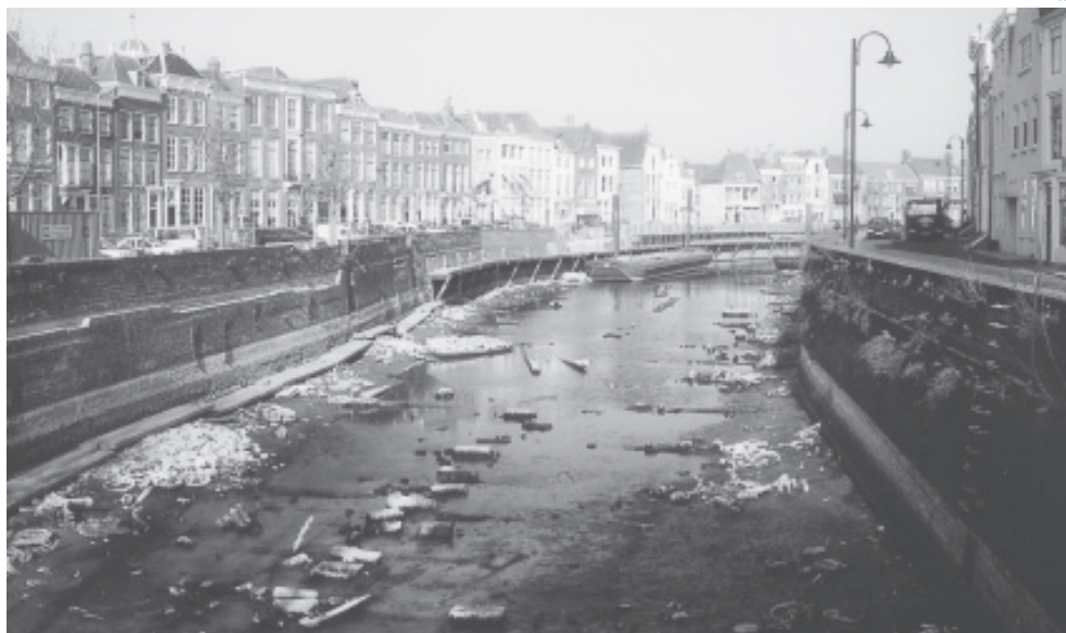
Ten tijde van de restauratie van de kademuren in april 2003. Puin, fietsen, winkelwagentjes en andere rommel bedekken de oude houten dokvloer. Duidelijk te zien zijn de voormalige dokblokken, waarop ontelbare schepen hebben gestaan. Het was 76 jaar geleden dat het dok voor de laatste keer werd drooggelegd, en dat was voor de reparatie van een schip. (Foto A.R. Koppejan)
