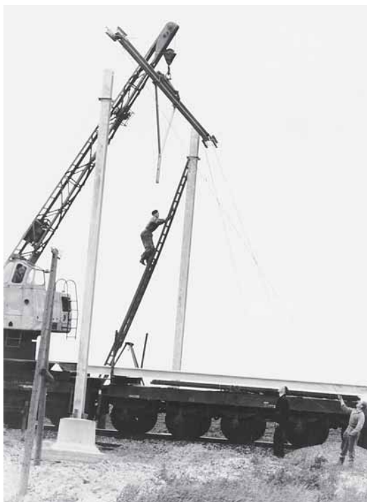
De aanleg van een bovenleidingmast op de Zeeuwse lijn, 1956. (Zeeuwse Bibliotheek, Beeldbank Zeeland, 5945, fotoarchief PZC)
